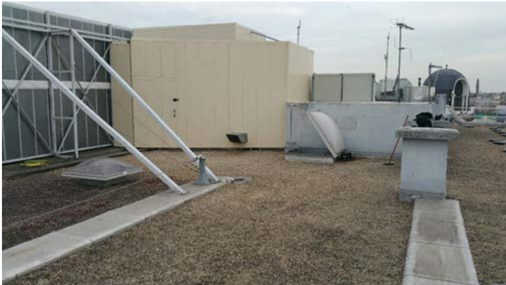
Situation corrigée avec capotage après intervention
