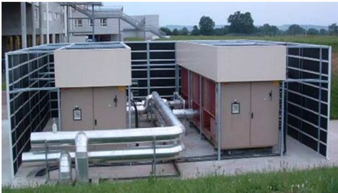
Ecran 3 faces avec « cheminées » acoustiques sur le rejet des groupes pour augmenter l'efficacité et éviter le recyclage d'air
