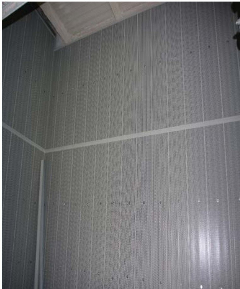
Traitement absorbant de local technique par panneau de laine de roche et protection mécanique par tôle perforée prélaquée. (Acouphon)
