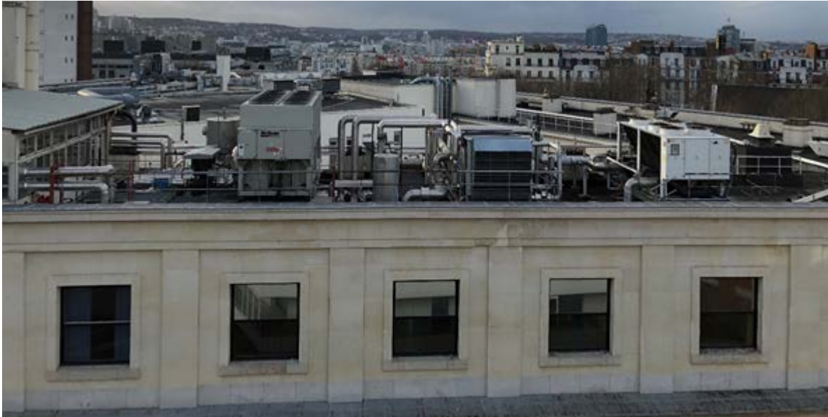
Nombreux équipements bruyants sur le toit du voisin
