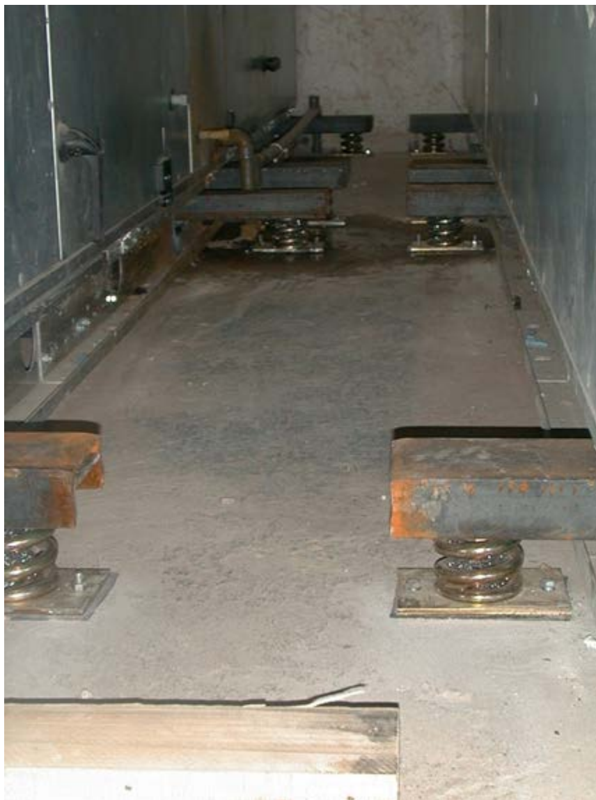
Plots à ressorts déportés pour limiter la hauteur dans un local existant
