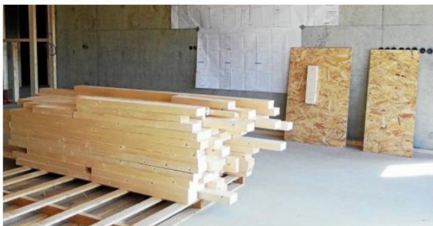
Le chantier utilise des matériaux écologiques.
